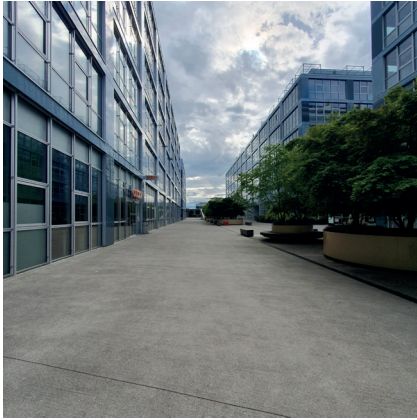
Diagnostic d'accessibilité universelle des espaces communs des bâtiments B-C-D de l'espace Tourbillon Plan-les-Ouates - Genève
